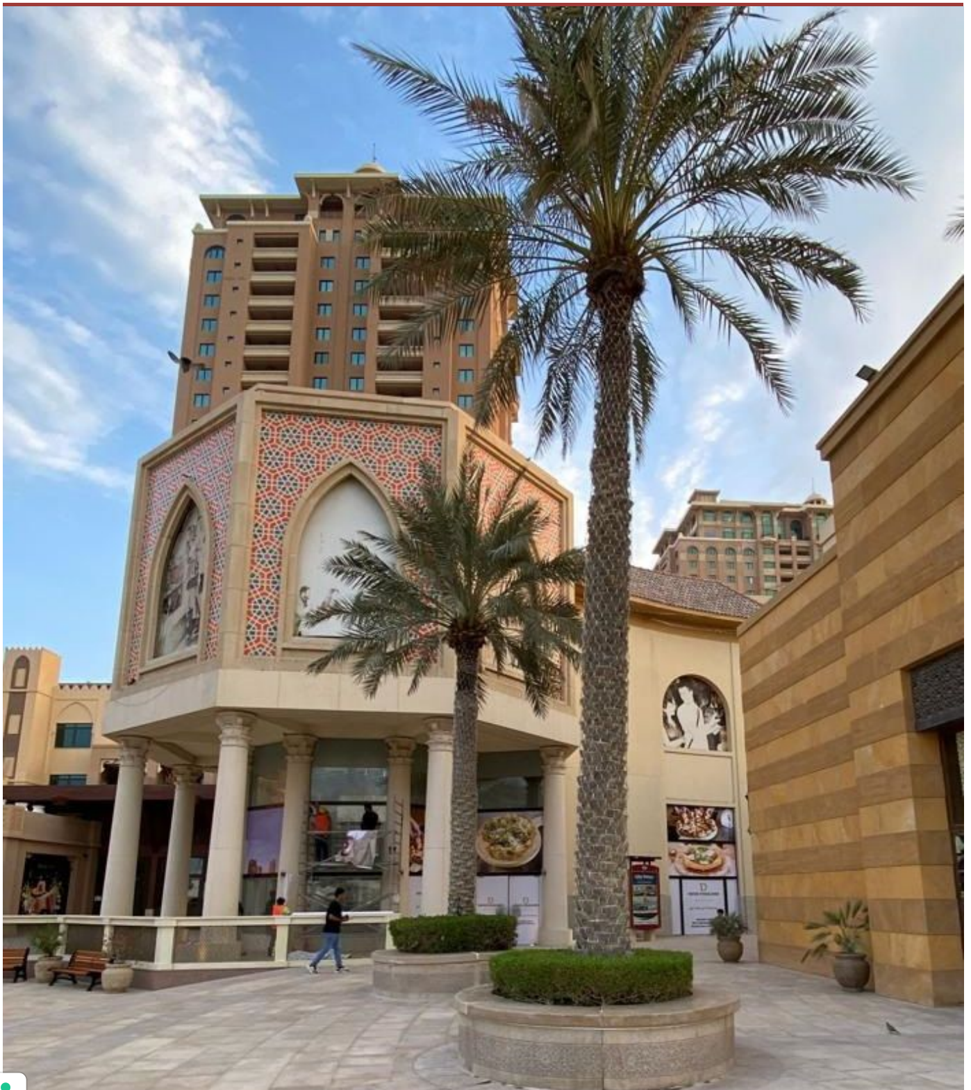
L'edificio che accoglierà la pizzeria qatariota di Vitagliano
